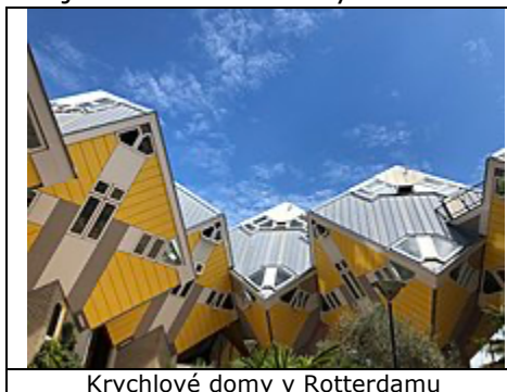
Krychlové domy v Rotterdamu
